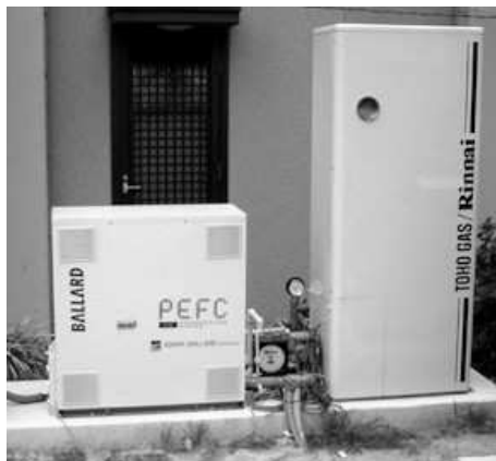
図-1 1kW 家庭用燃料電池システムの外観。左は燃料電池本体、右は排熱利用給湯暖房システム
