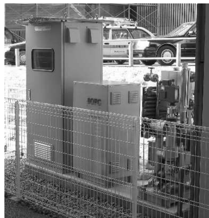
図-2 愛知万博のガスパビリオンに設置した固体酸化物形燃料電池 (SOFC) システム
